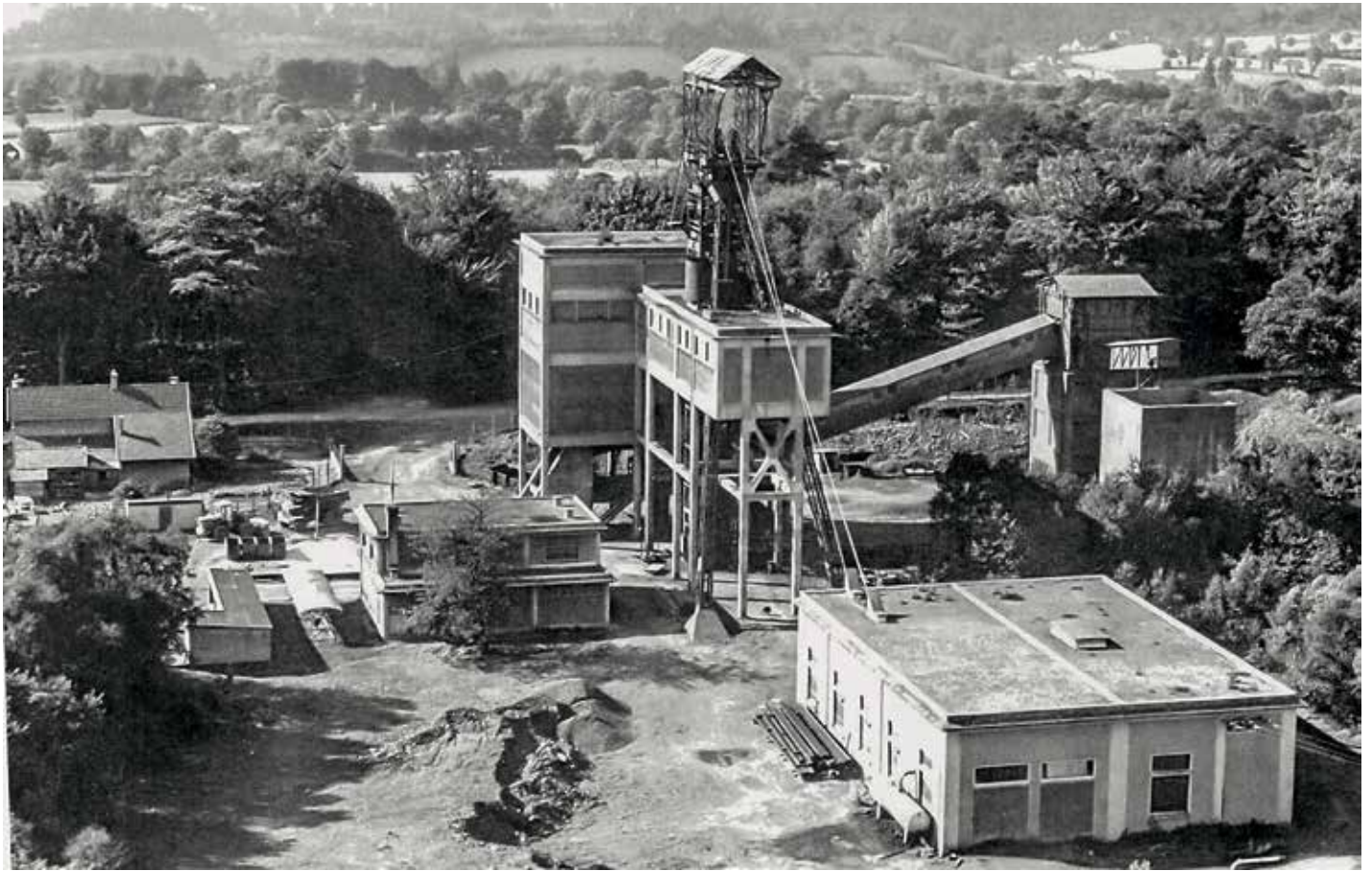
Abb. 5 oben: Ein Blick aus der Vogelperspektive auf die Eisenerzgrube Saint-Clair-de-Halouze in ihrer letzten Betriebsperiode bis 1978. Das Fördergerüst trägt noch die heute abgerostete giebelförmige Überdachung, um die es nach der Montage in Frankreich ergänzt worden ist. Im Vordergrund das heute leerstehende Fördermaschinenhaus nebst Elektrozentrale. Links davon das ehemalige Kauen- und Bürogebäude. (Archiv des Museums Maison du Fer, Dompierre, Frankreich)
