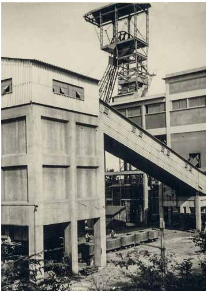
Abb. 5 oben: Ein Blick aus der Vogelperspektive auf die Eisenerzgrube Saint-Clair-de-Halouze in ihrer letzten Betriebsperiode bis 1978. Das Fördergerüst trägt noch die heute abgerostete giebelförmige Überdachung, um die es nach der Montage in Frankreich ergänzt worden ist. Im Vordergrund das heute leerstehende Fördermaschinenhaus nebst Elektrozentrale. Links davon das ehemalige Kauen- und Bürogebäude. (Archiv des Museums Maison du Fer, Dompierre, Frankreich)
